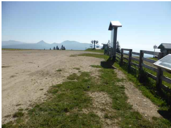
Plateforme d'arrivée du télésiège
