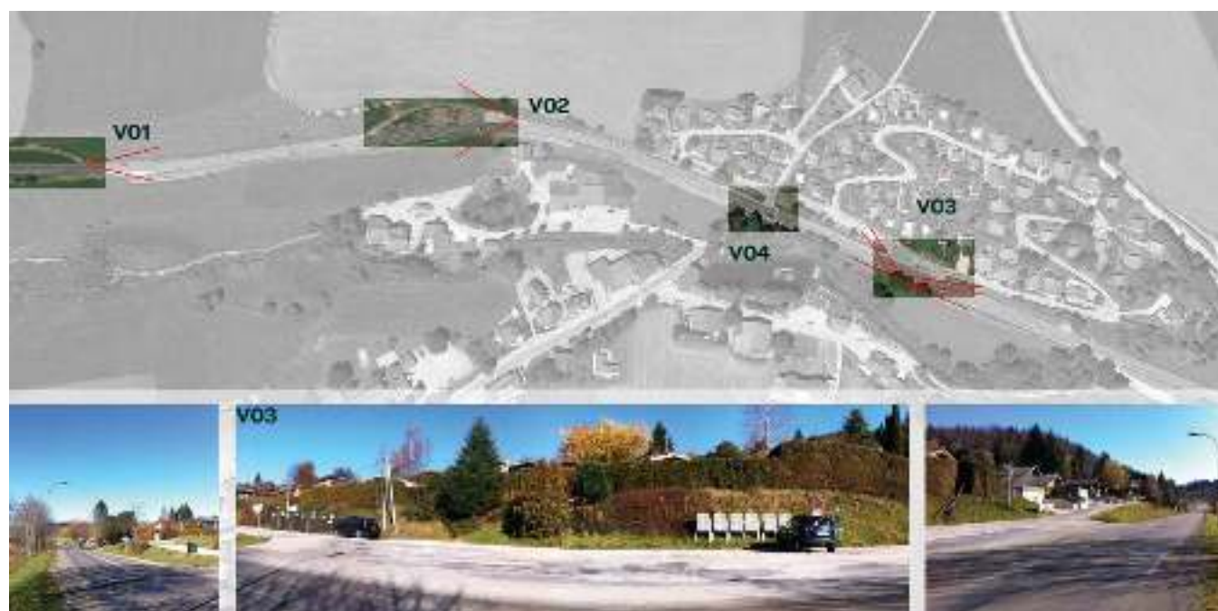
Figure 16 : Approche par la RD9, entrée Est du village (source : Etude ARTER, Février 2015)
