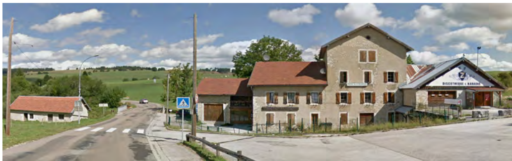
Ensemble des bâtiments classés, façade sud (source Google Maps)
