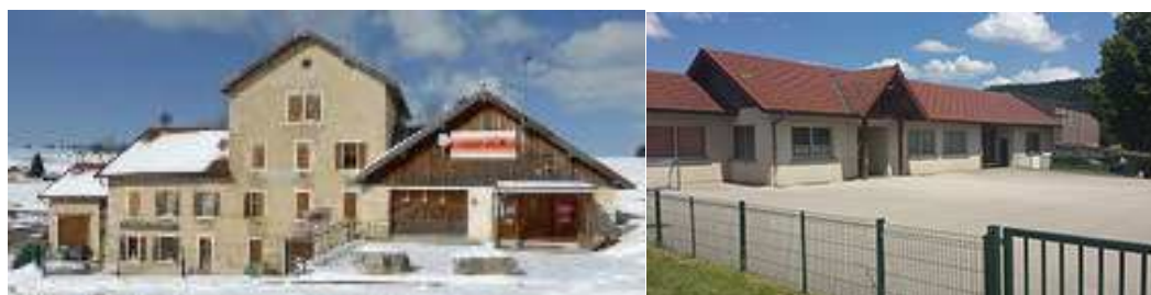
Halte-garderie et école élémentaire de Métabief
